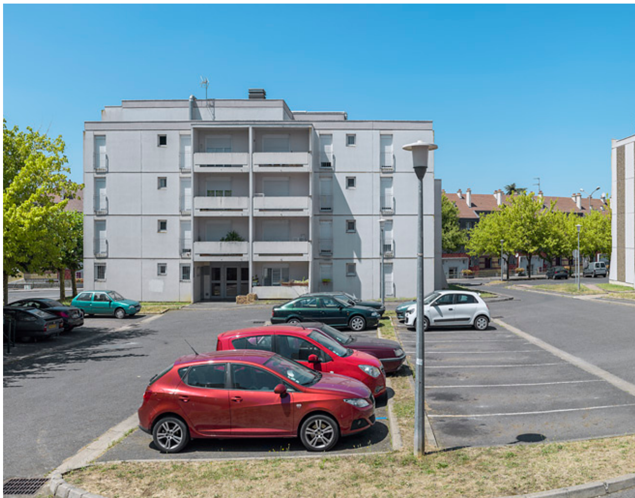
Bâtiment 25, façade antérieure est.
