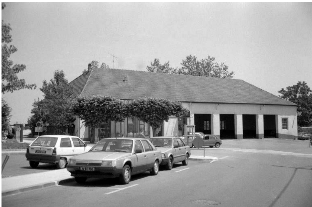
Vue d'ensemble depuis le jardin, au nord.
