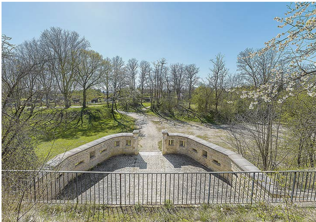
Le ravelin depuis la terrasse des casernes.
