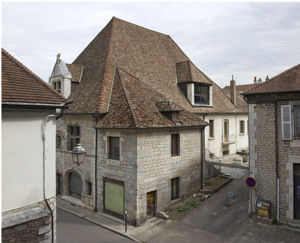
Façade rue Rivotte, de trois quarts droit.
