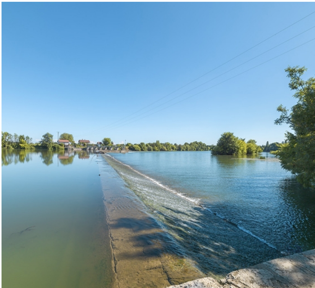
Le déversoir du barrage.
