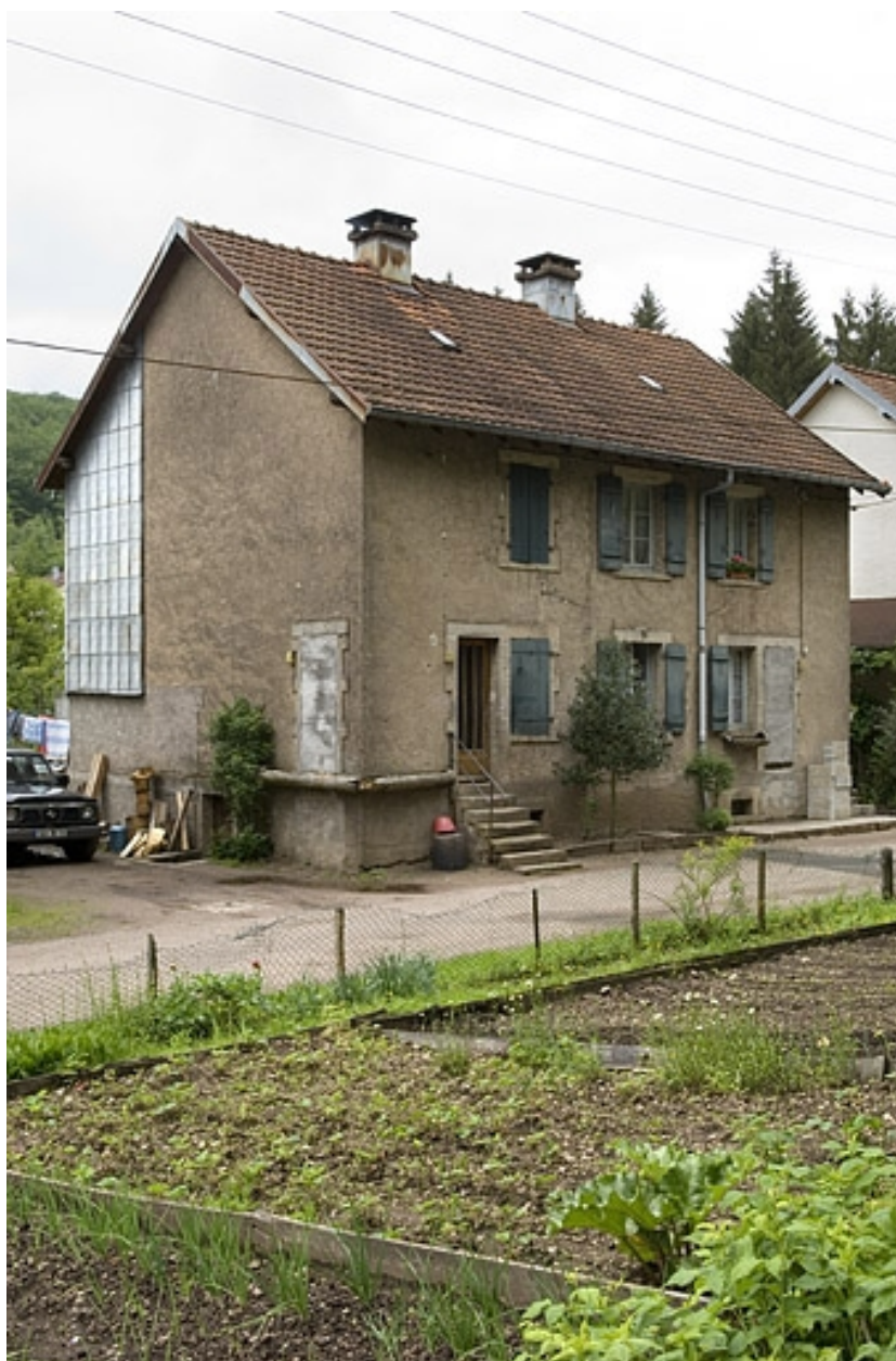
Logement ouvrier double (rue du Barrage).
