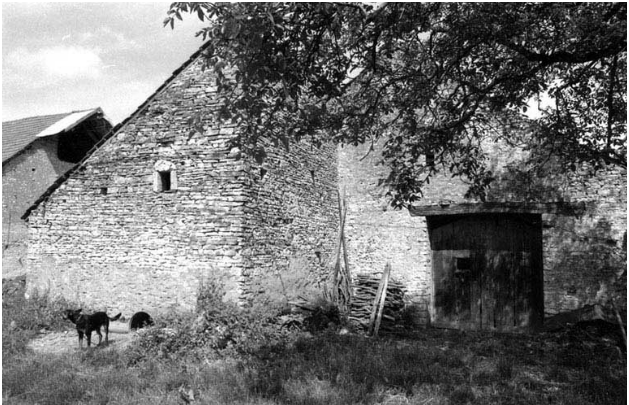
Remise et four : façade sur rue.
