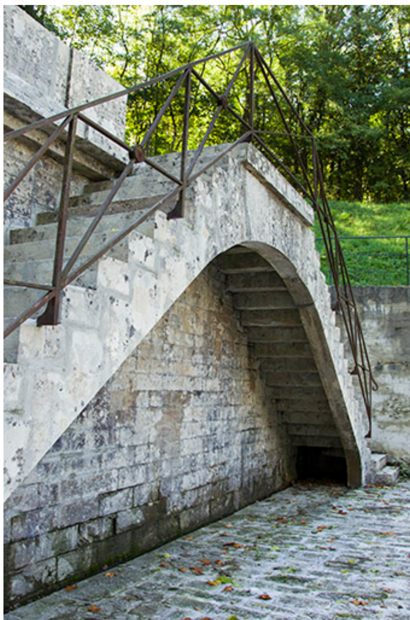
Escalier double, terrasse surplombant l'entrée du souterrain.
