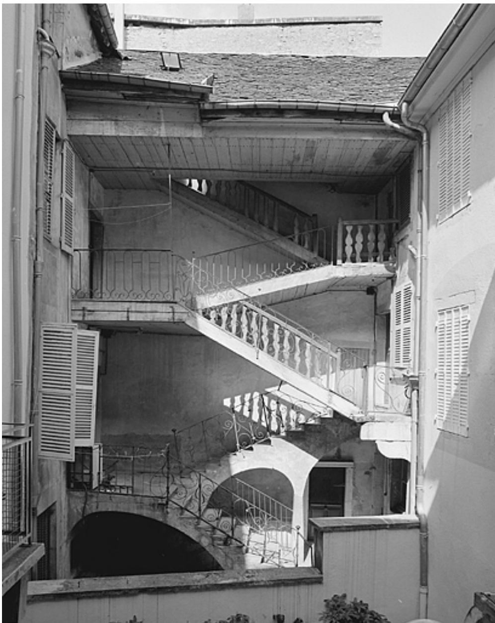
Escalier dans la cour.
