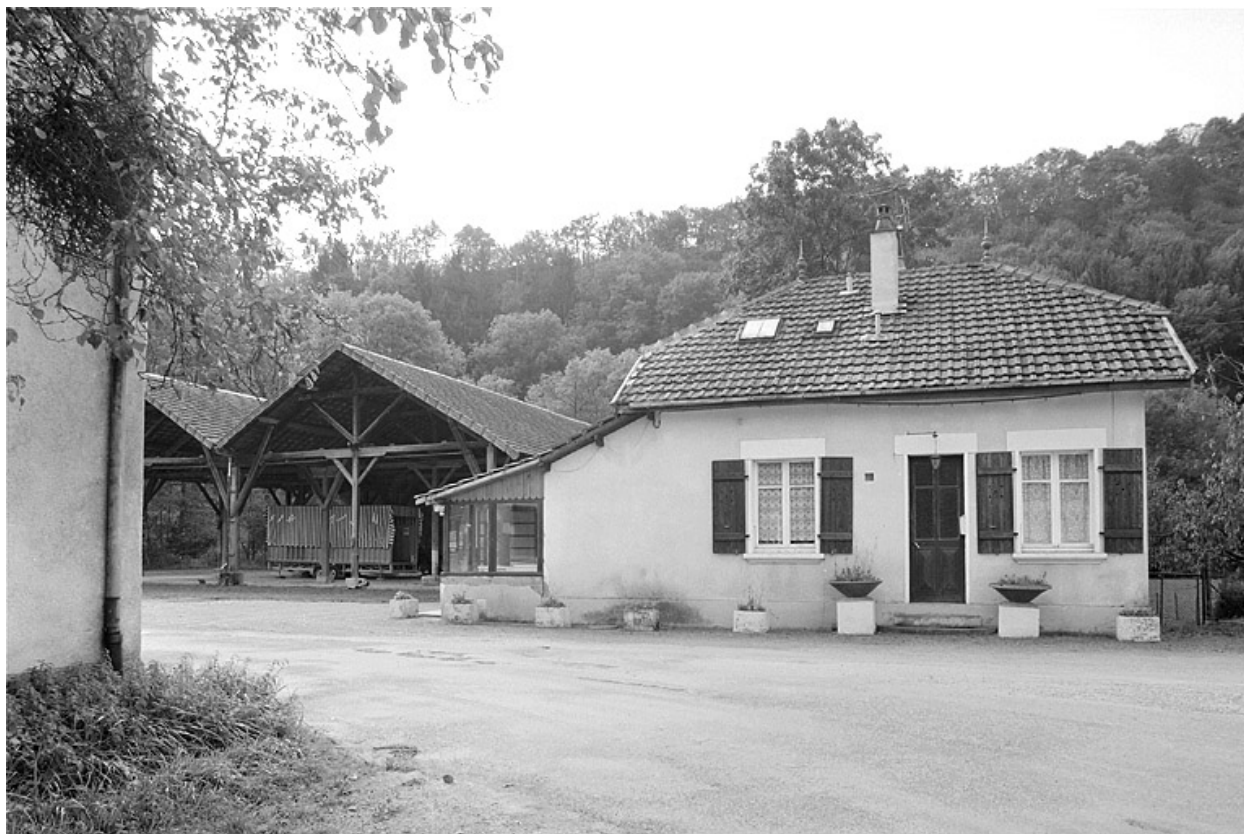
Façade nord de la conciergerie.
