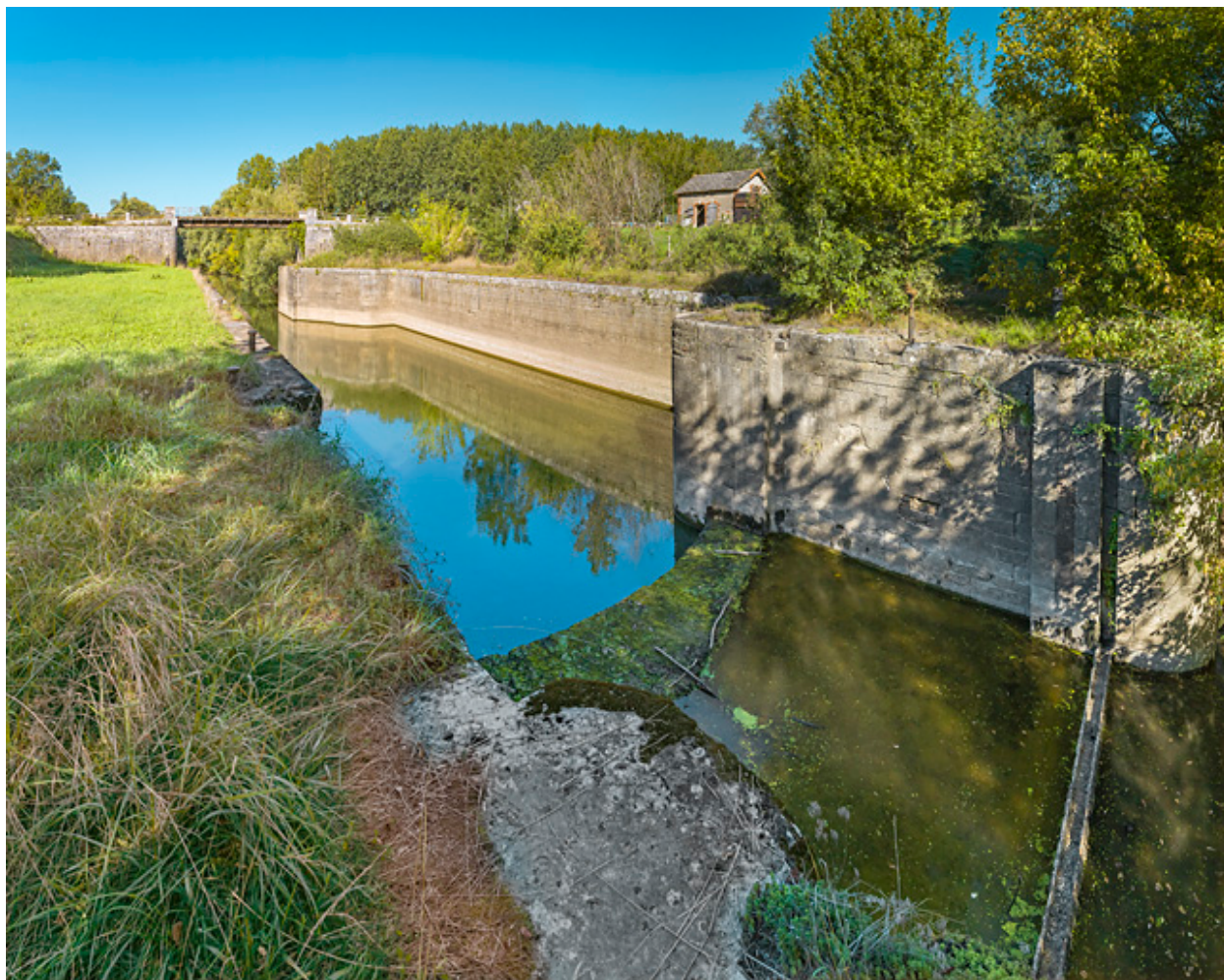
Le sas et l'emplacement des portes.
