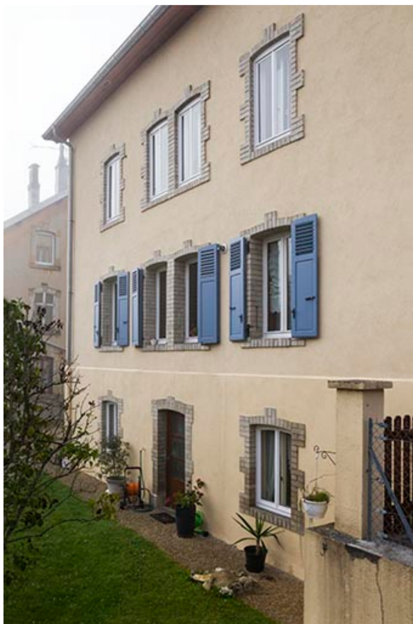
Façade postérieure, vue en enfilade.
