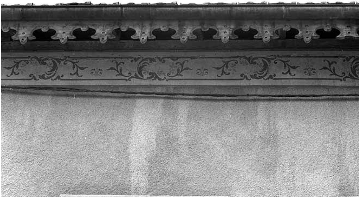
Détail d'une planche de rive et de décor de façade de la ferme transformée en maison..
