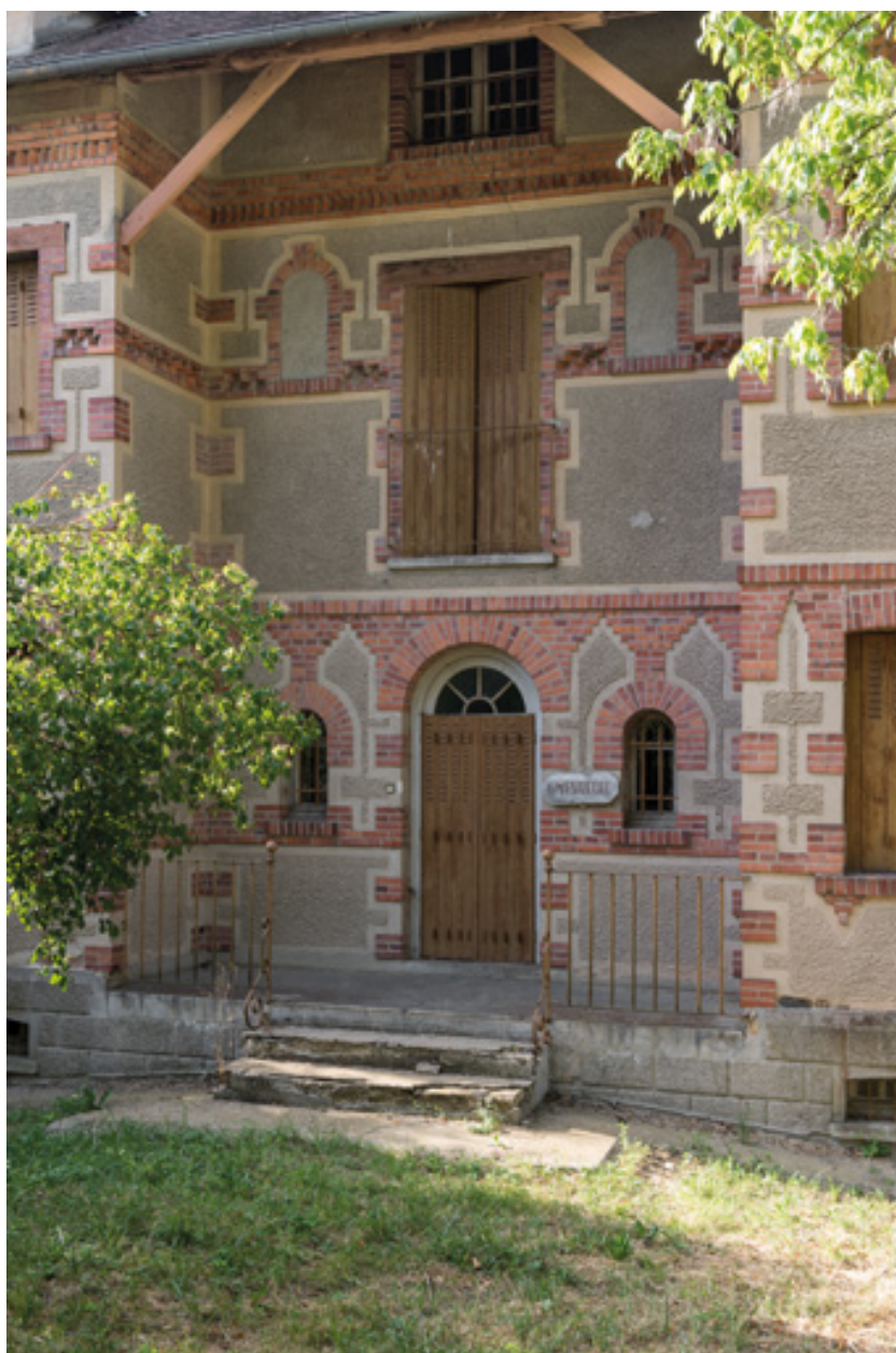
Façade principale, arrière-corps central.
