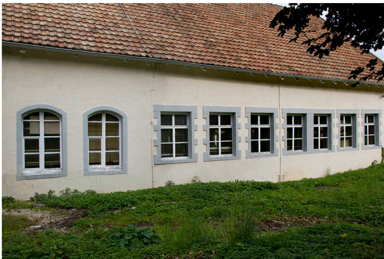
Atelier de 1888, côté pré : détail des fenêtres.
