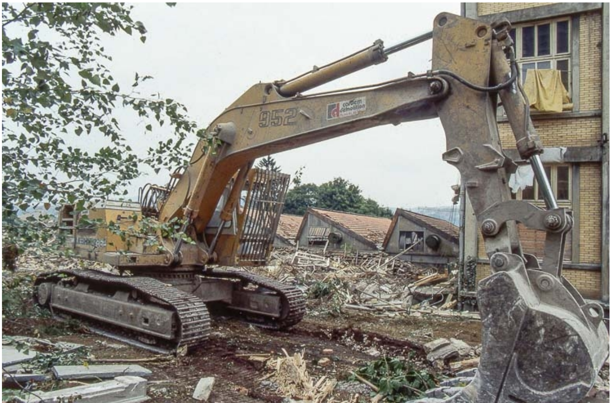
Destruction de l'usine, 23 août 1993 : pelle mécanique.
