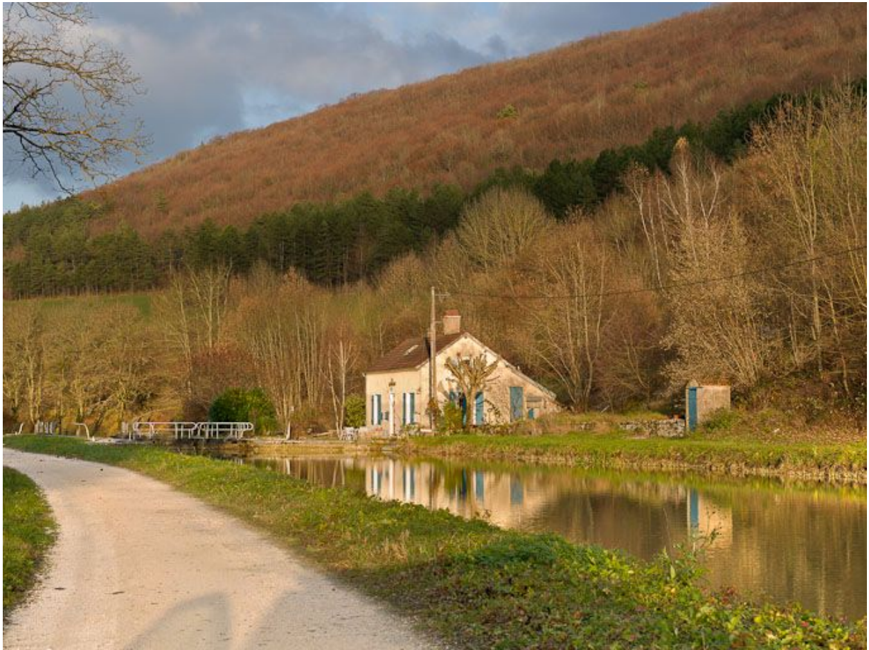
Vue d'ensemble du site d'écluse.
