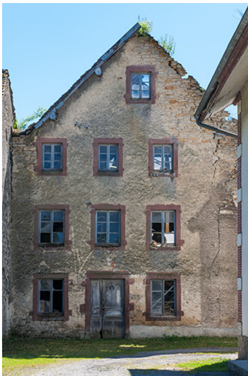
Pignon nord du moulin.
