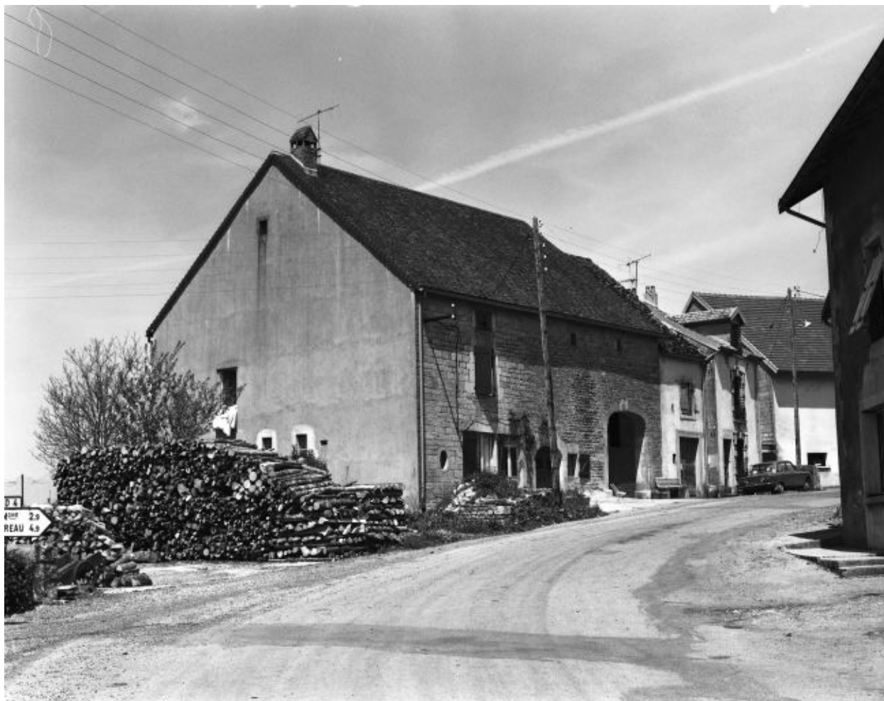
Façade antérieure vue de trois-quarts gauche en 1981.
