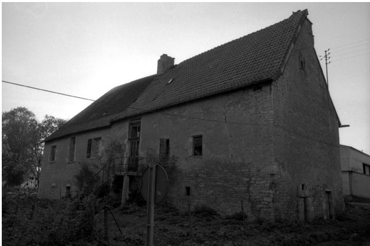
Partie agricole : façade postérieure.
