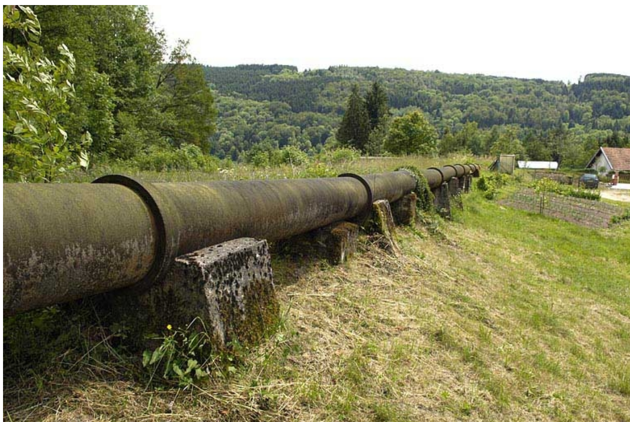
Détail de la conduite forcée.
