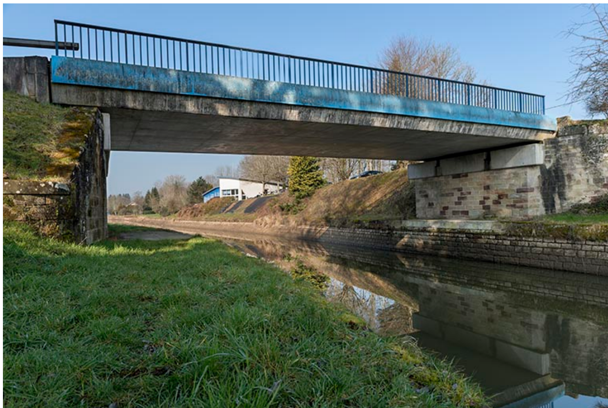
Pont routier enjambeant le canal, Pont-du-Bois (70).
