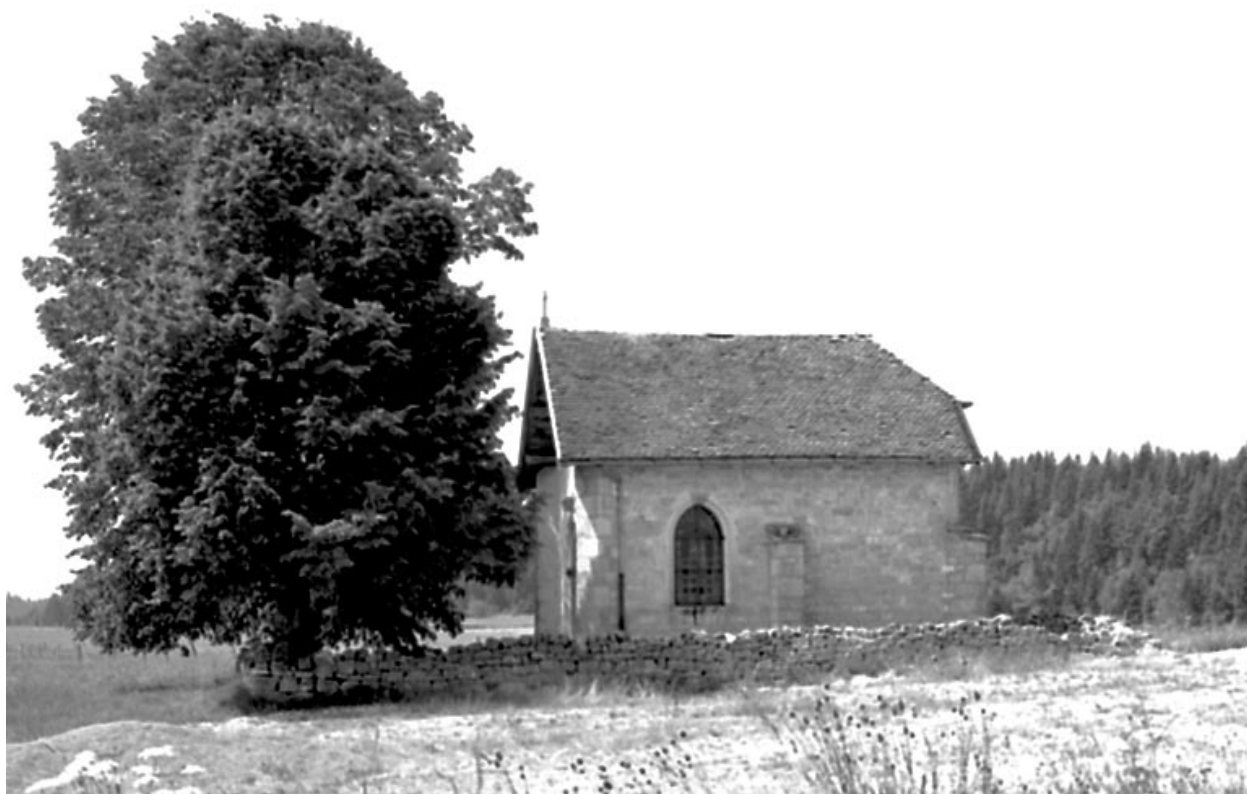
Façade latérale sud.
