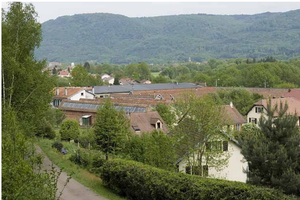
Vue plongeante depuis le nord-ouest.
