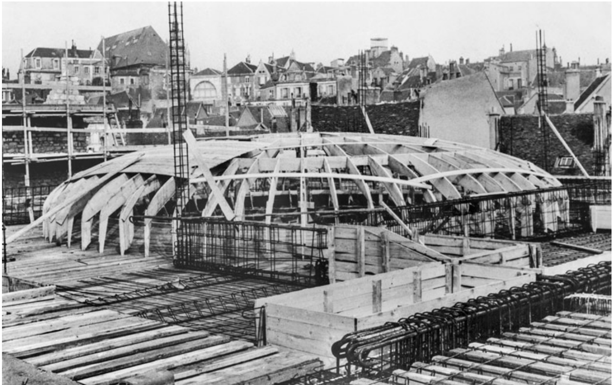
1er tableau : [2C] La coupole en construction, 1938.
