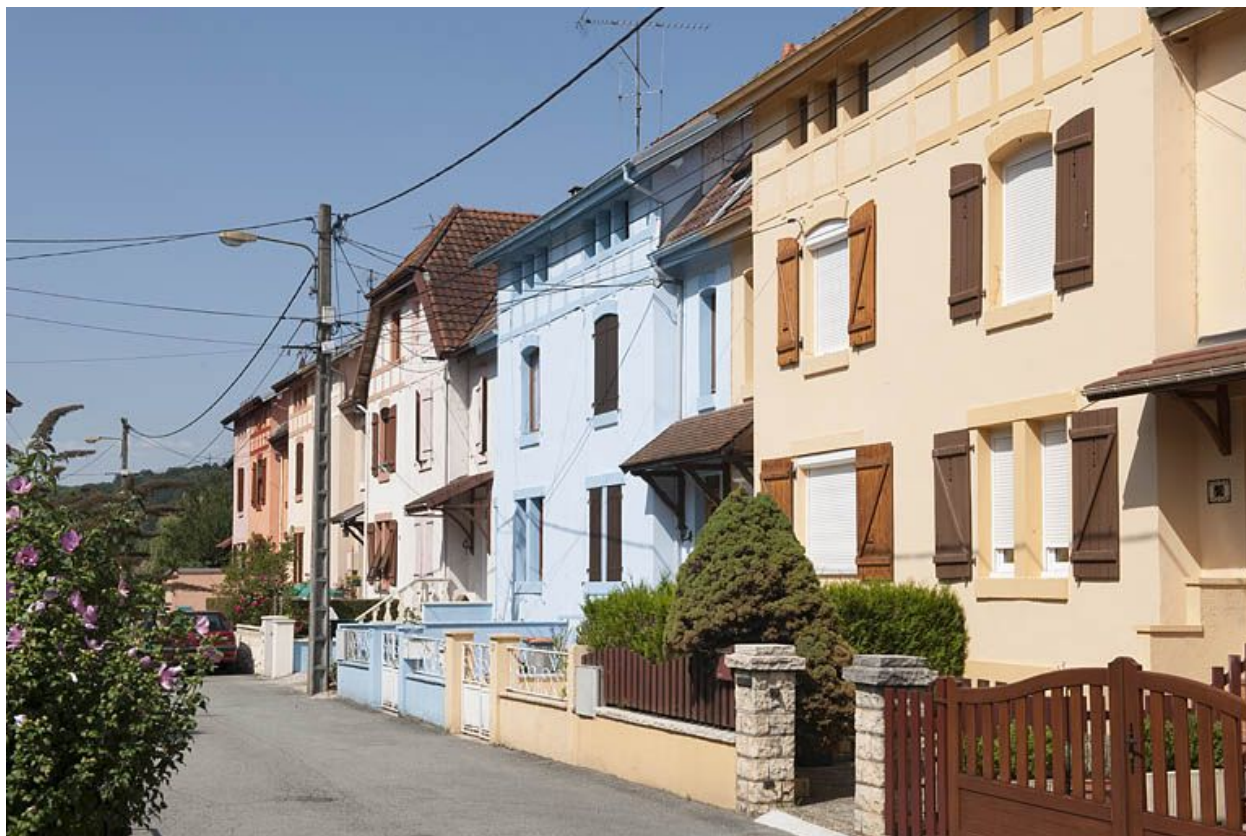
Vue rapprochée de l'immeuble rue de Flandres.
