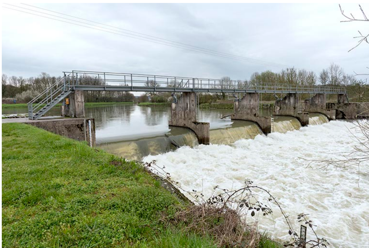
Le barrage mobile de Saint-Albin.
