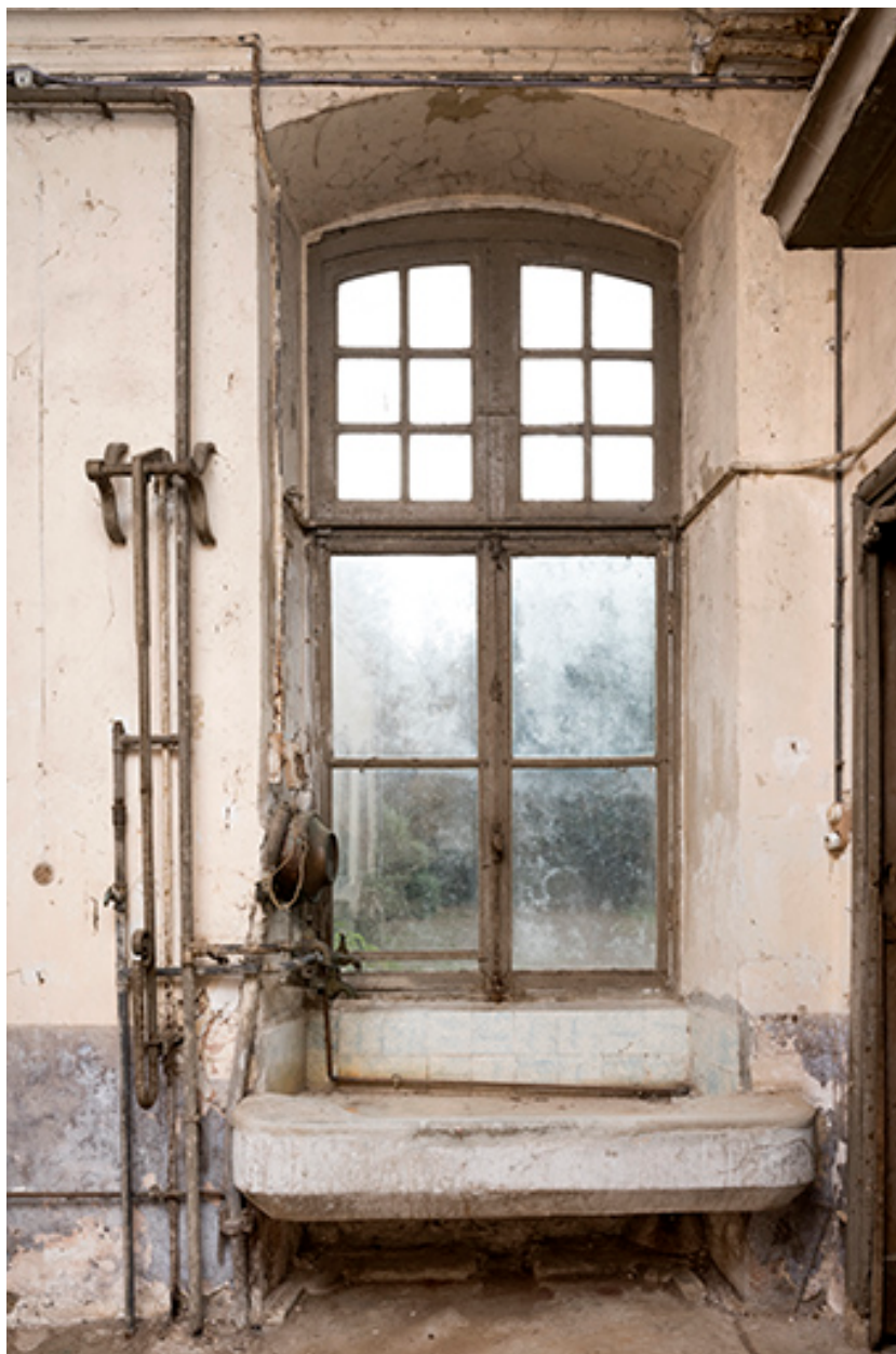
Rez de chaussée, cuisine, pierre d'évier.
