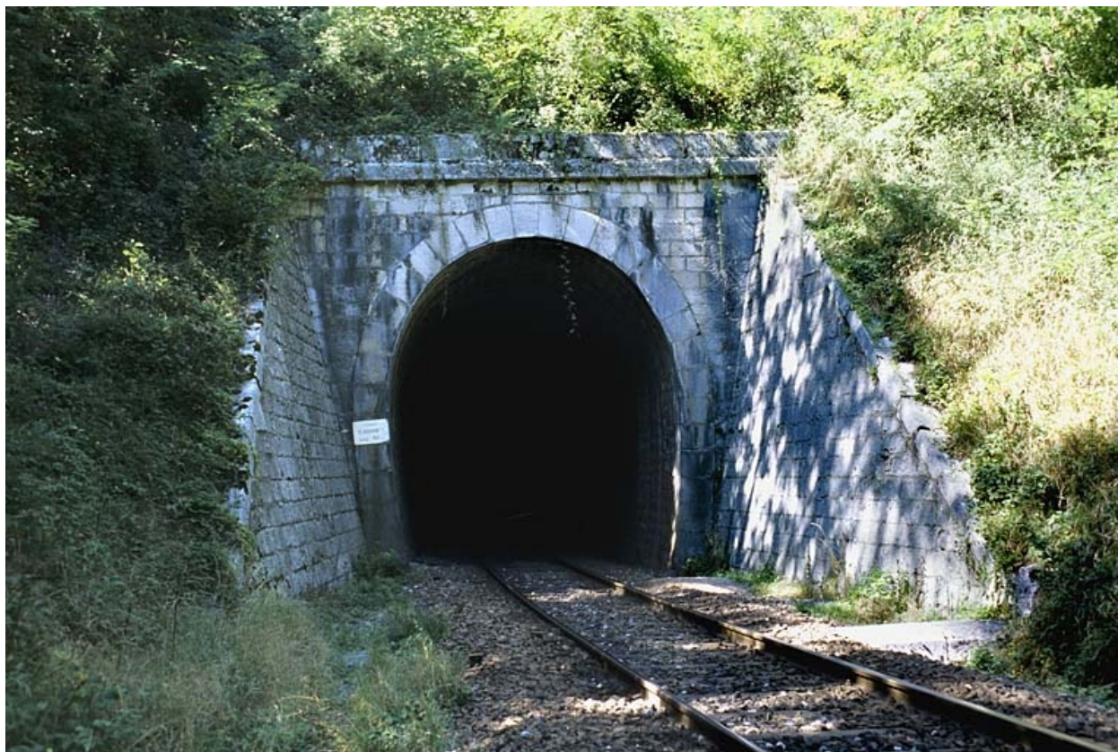
Tunnel d'Arbent 1 : tête côté La Cluse (sud-est).
