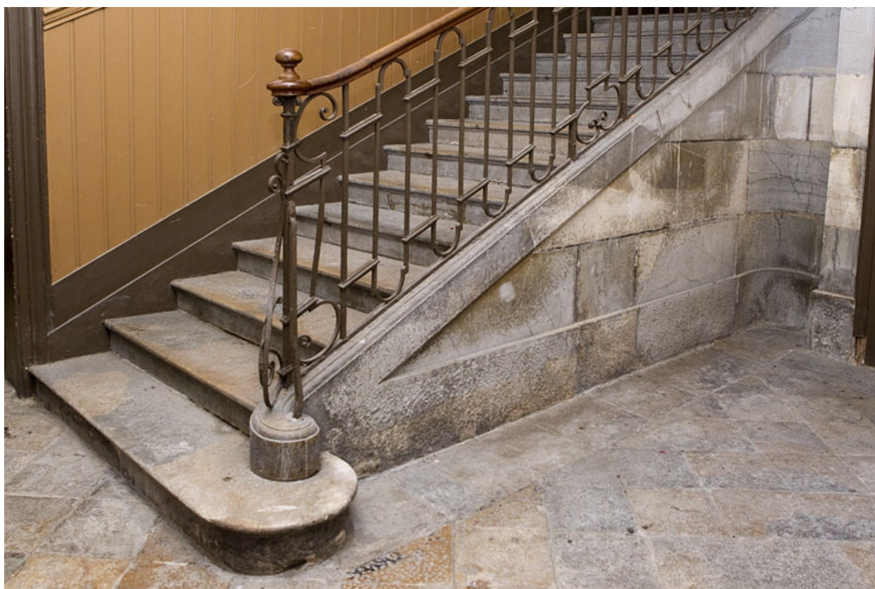
Détail du départ de l'escalier.
