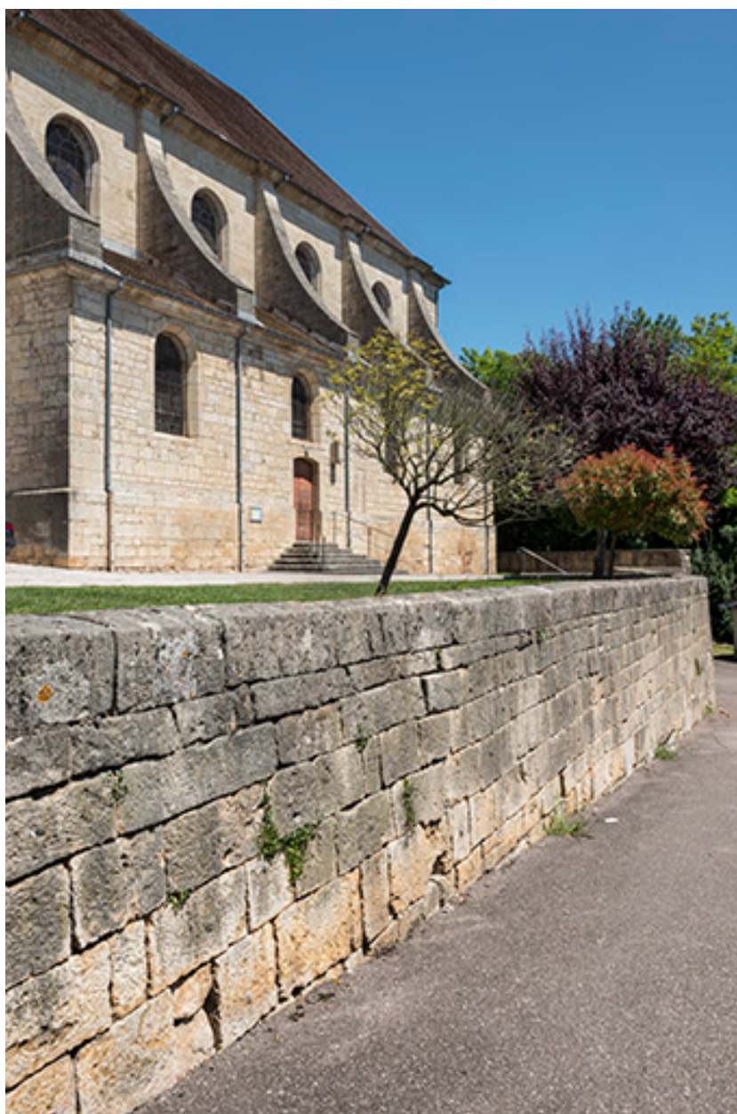
Flanc sud, mur de l'ancien cimetière.
