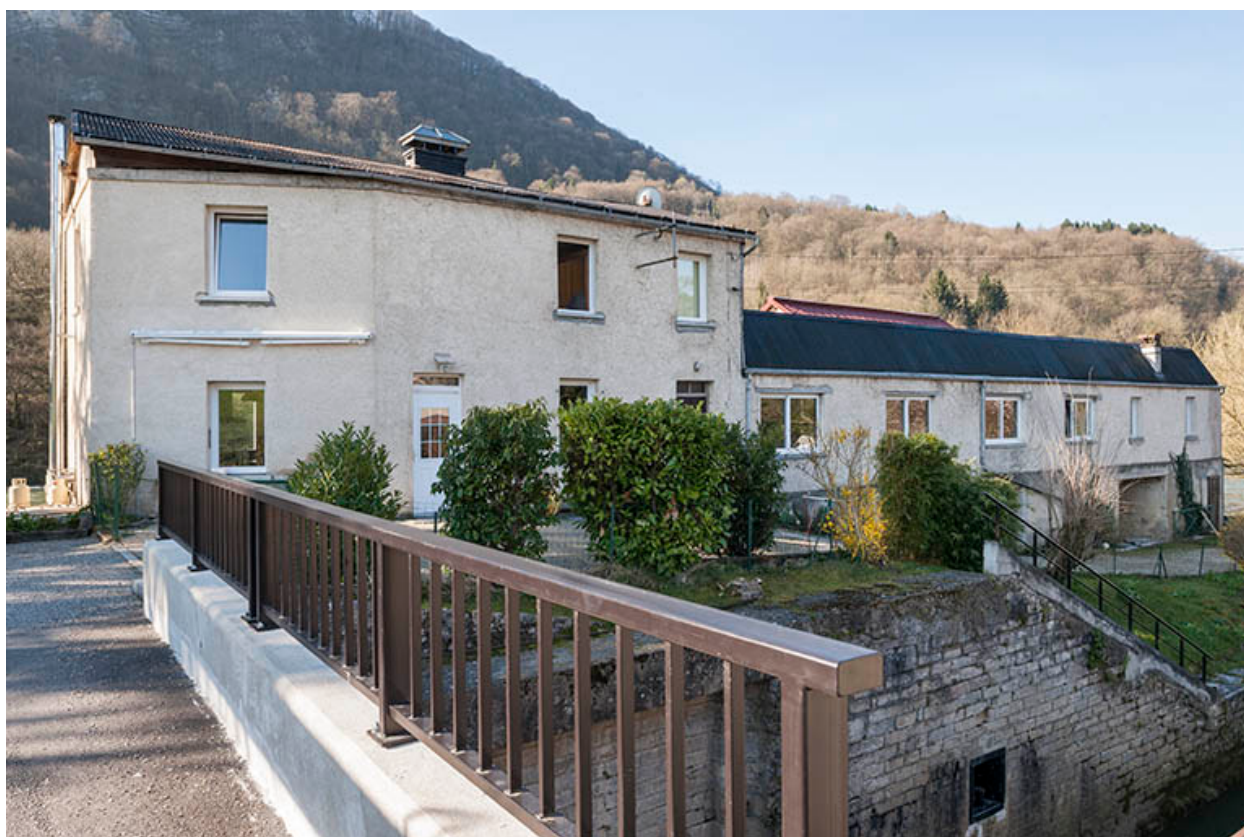
Logement et atelier de fabrication depuis l'écluse.
