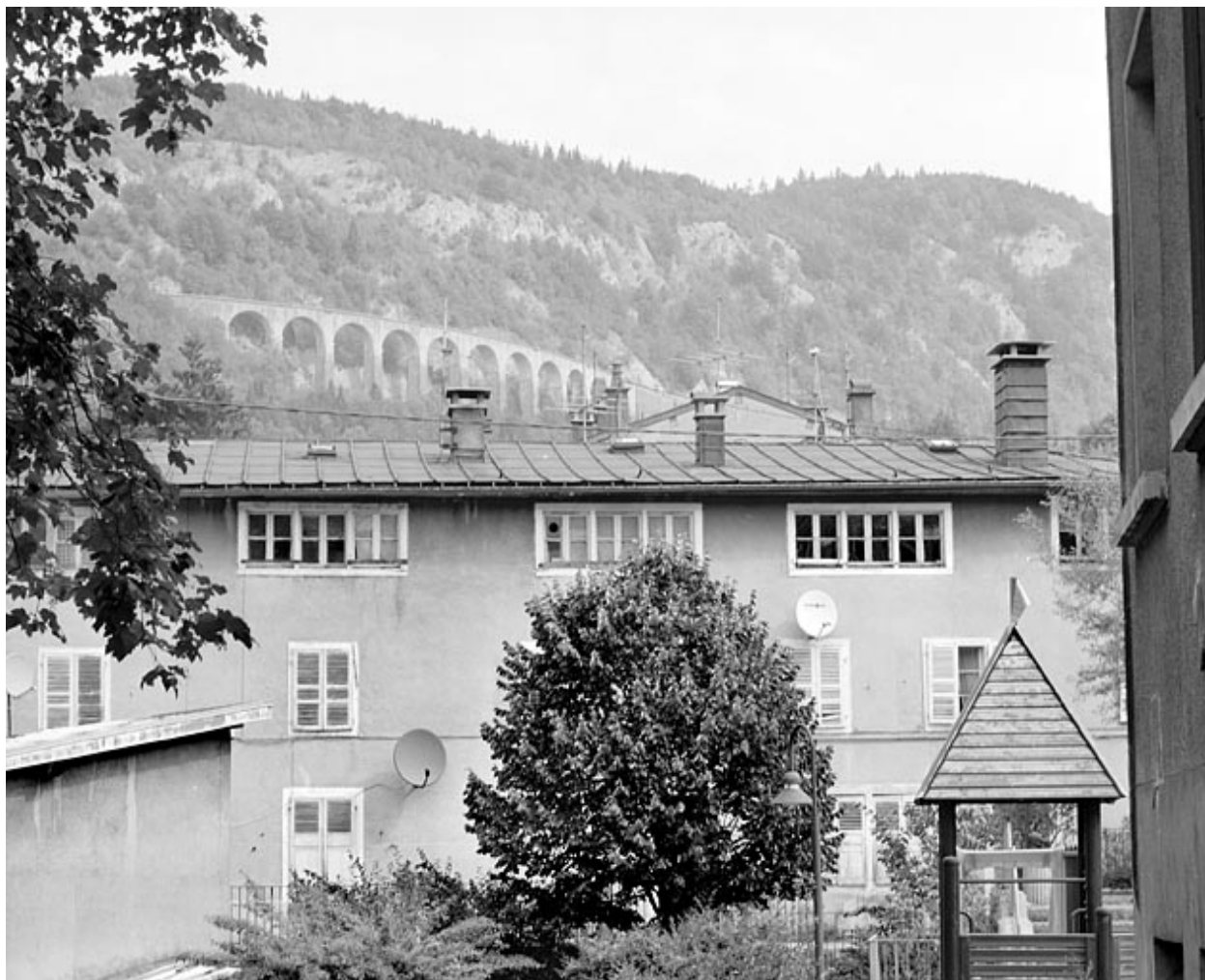
Façade principale : ensembles de baies lunetières.
