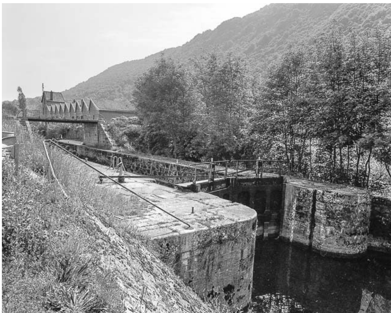
Vue de l'usine depuis l'écluse en 1976.
