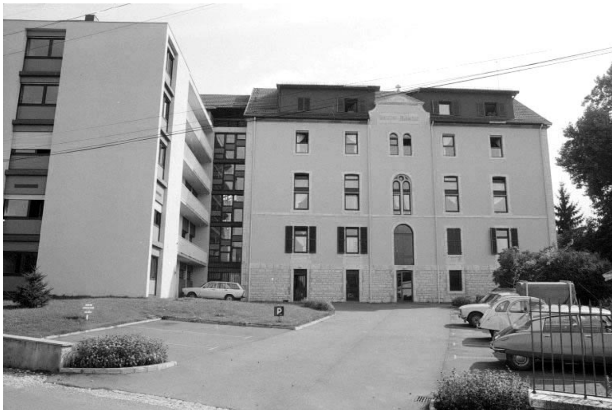
Façade antérieure et annexe.
