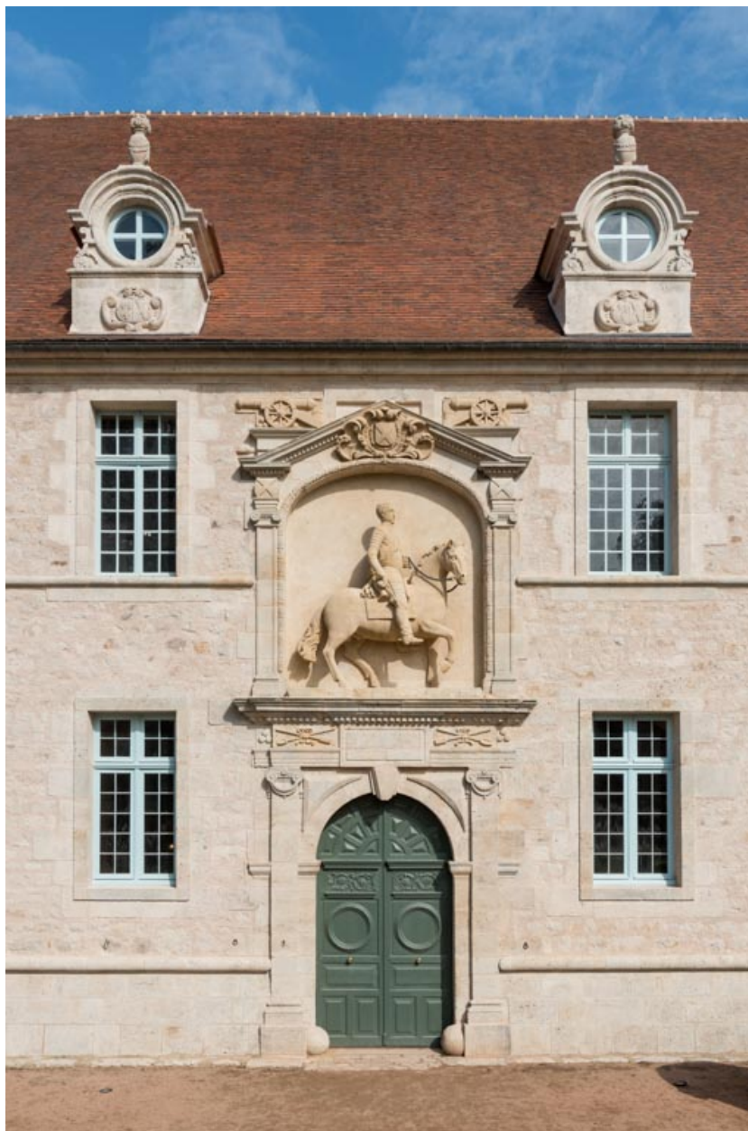
Façade sud-est, travée centrale, après restauration.
