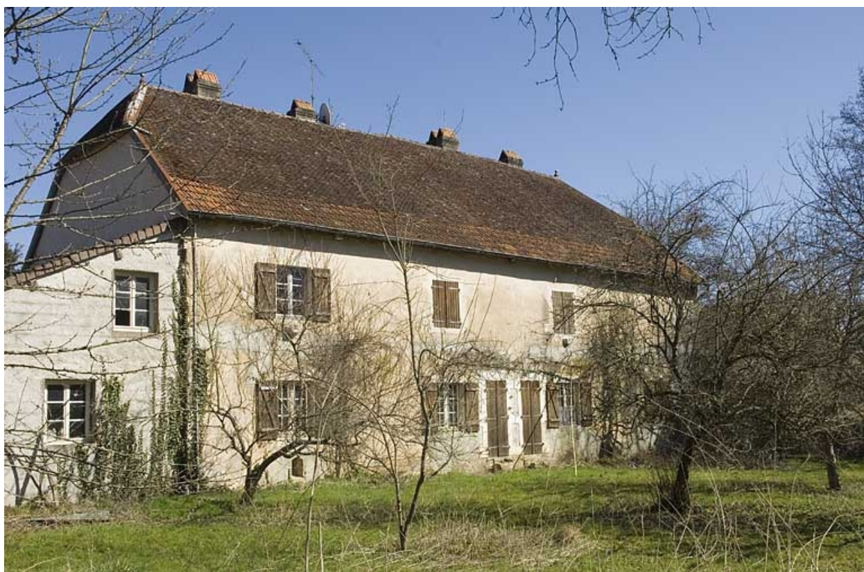
Logement d'ouvriers. Façade postérieure.
