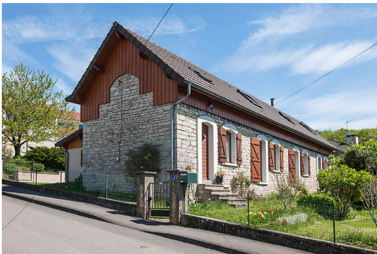
Logements ouvriers contigus (6 rue des Ranchots).
