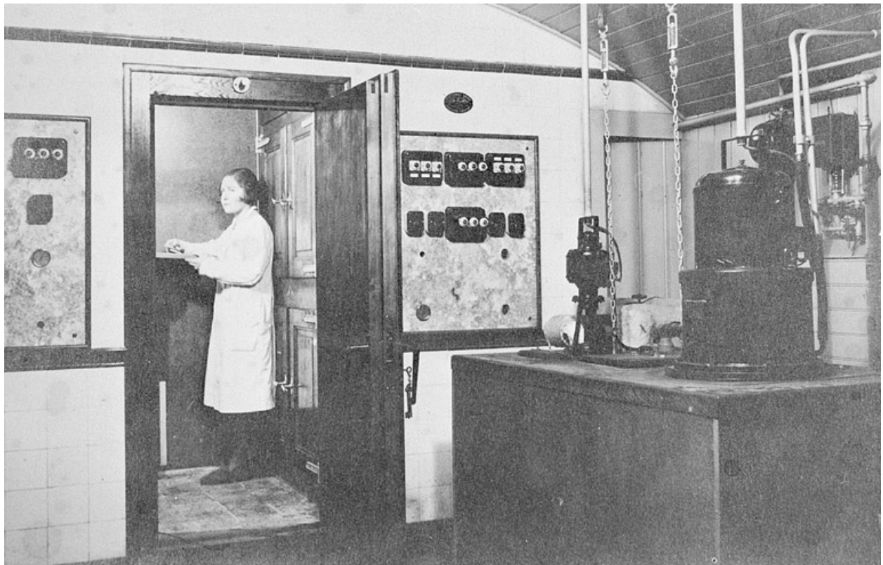
Service des Chronomètres. Appareil frigorifique Barthod (Autofrigor Eysher Wiss), 1932.
