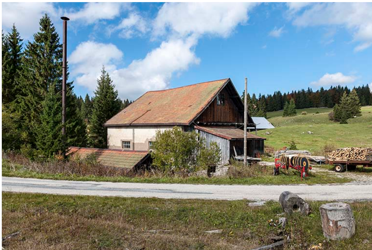
Scierie des Mortes, Chapelle-des-Bois (les Mortes).
