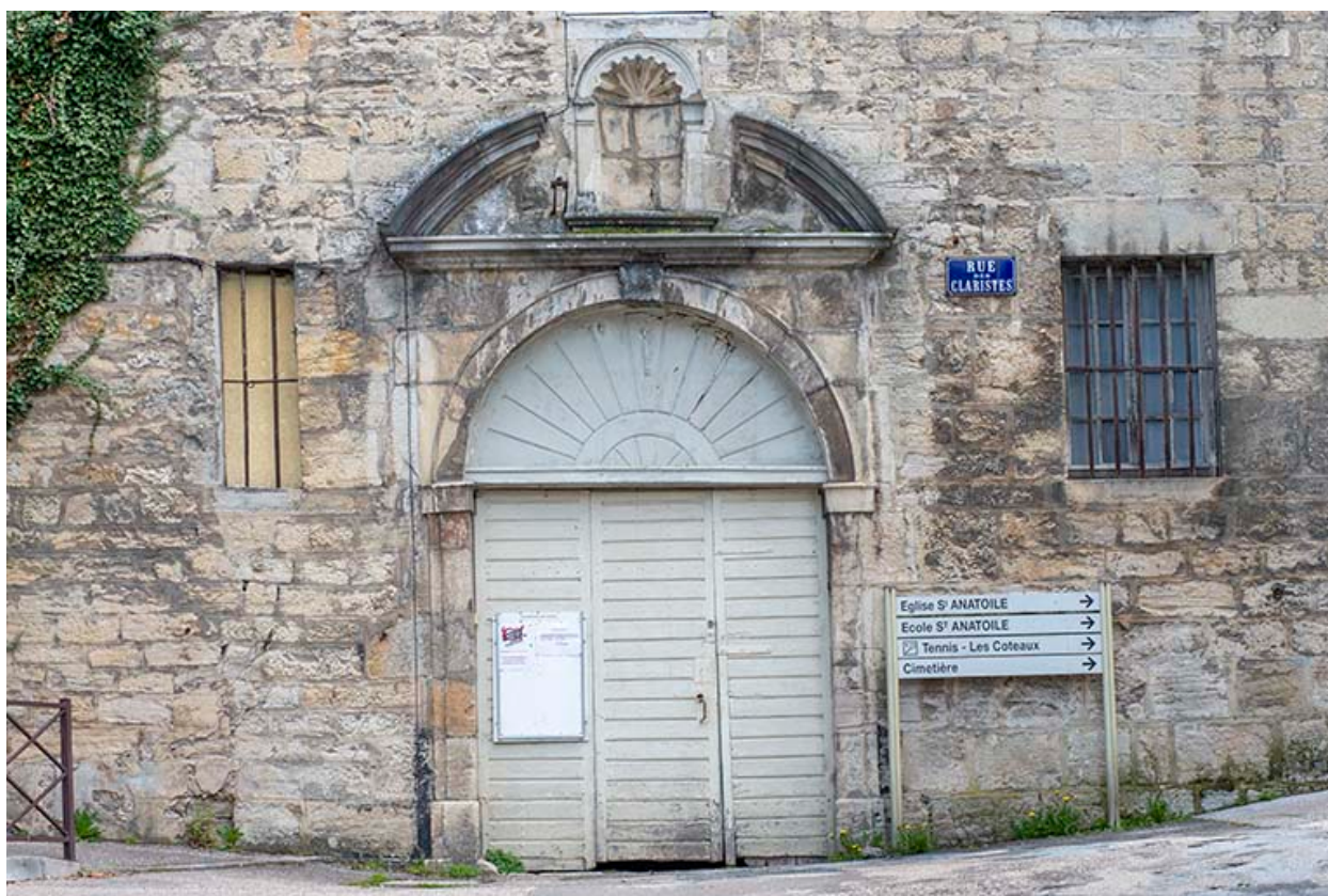
Porte principale du bâtiment sur rue.
