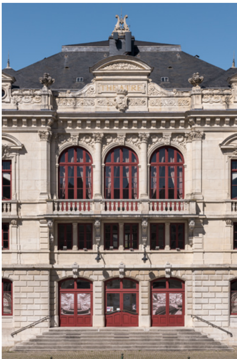
Façade antérieure : travée centrale.
