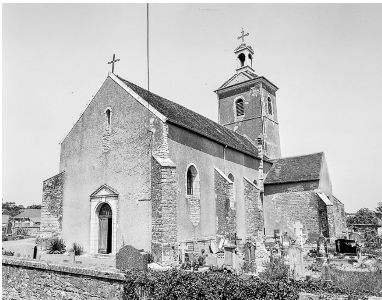
Façades antérieure et latérale droite.
