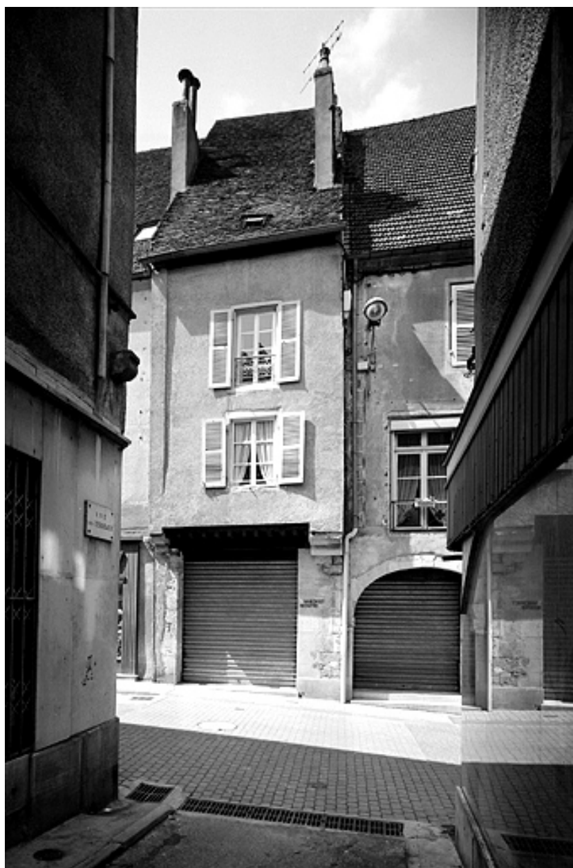
Façade antérieure : de face.
