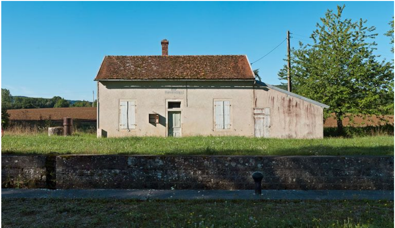
Vue de face de la maison éclusière.
