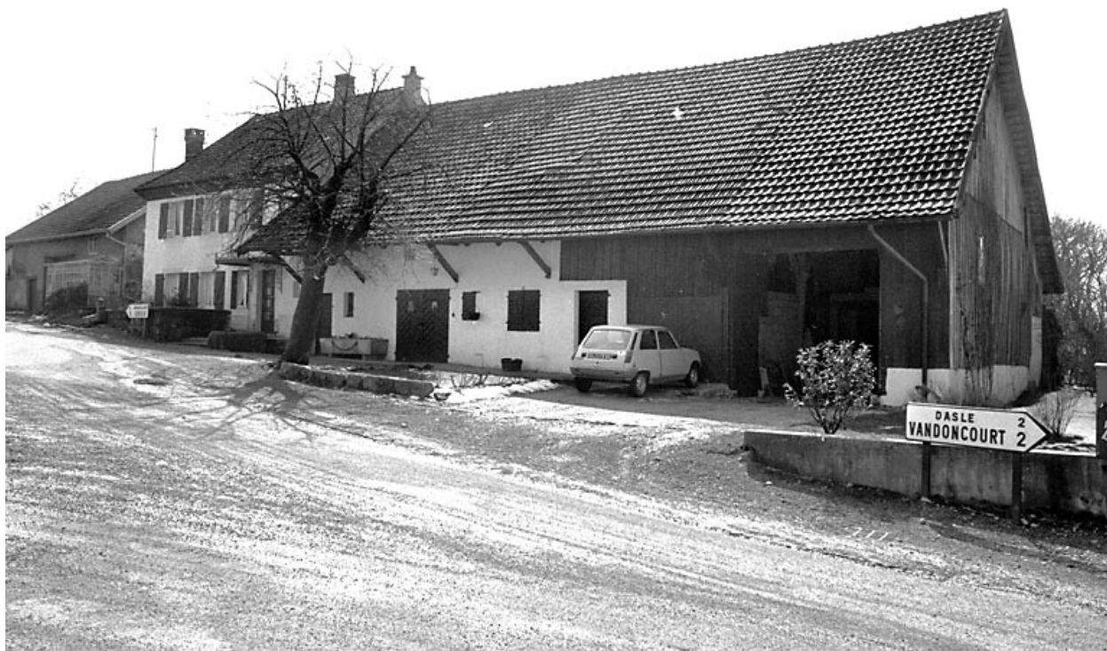
Montbouton : ferme située 1 rue du Mont Novel.
