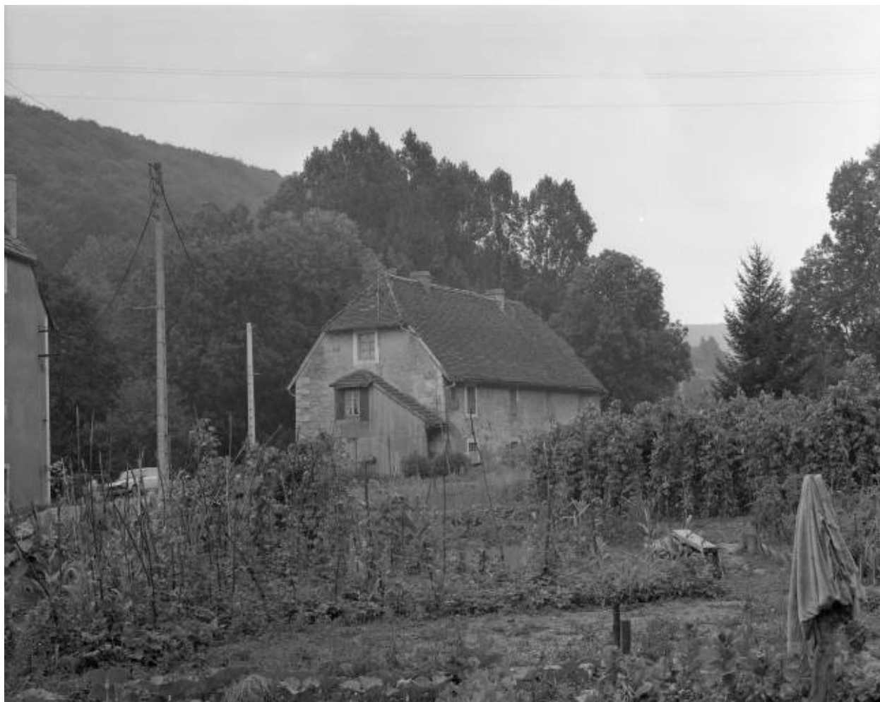
Logement ouvrier depuis le nord en 1981.
