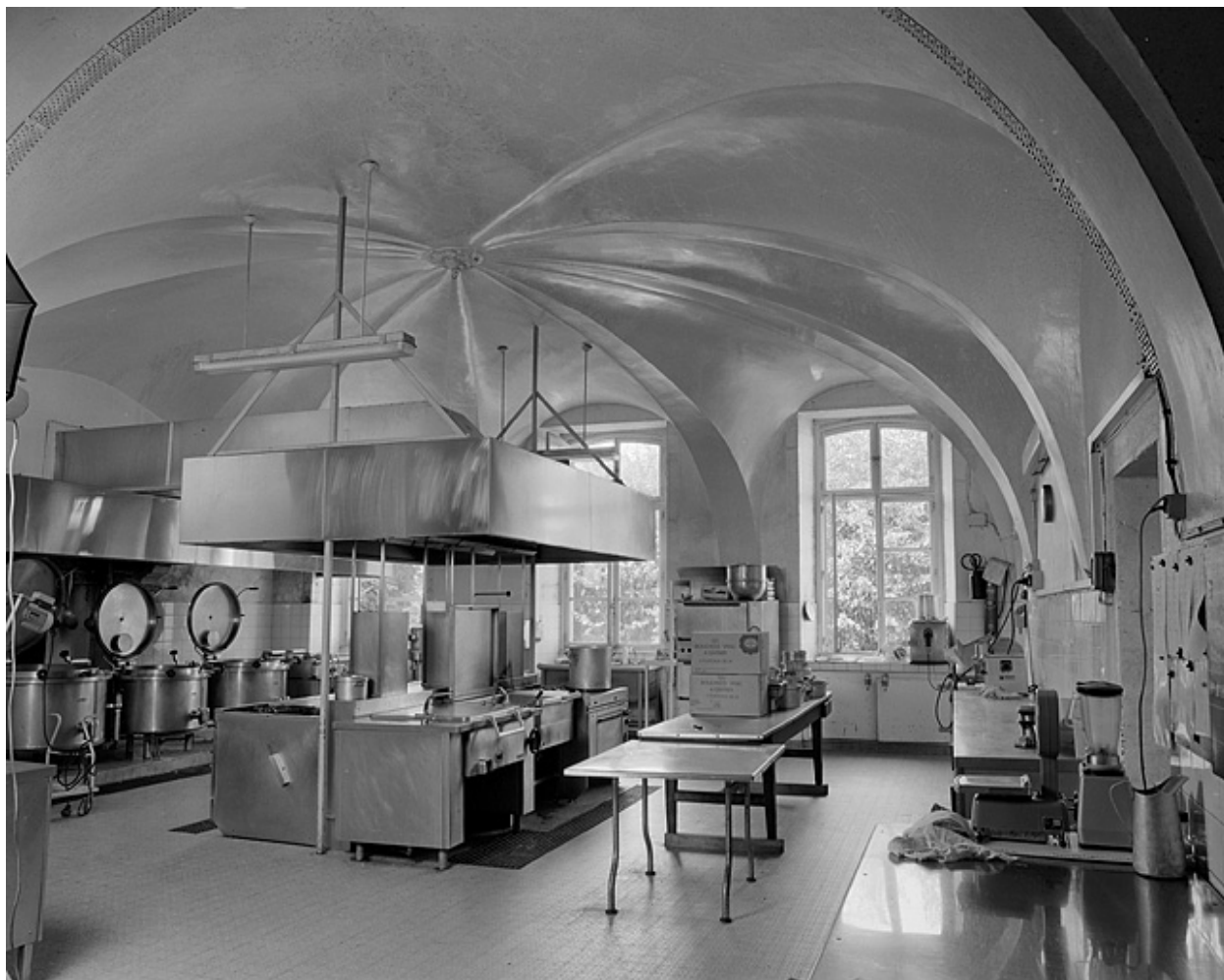
Cuisines : vue d'ensemble.
