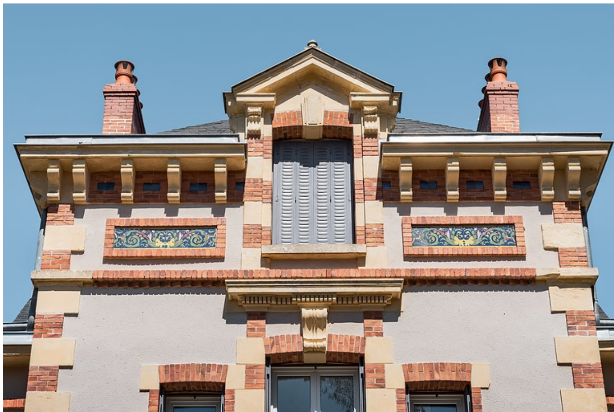
Avant-corps central de la façade principale, détail.
