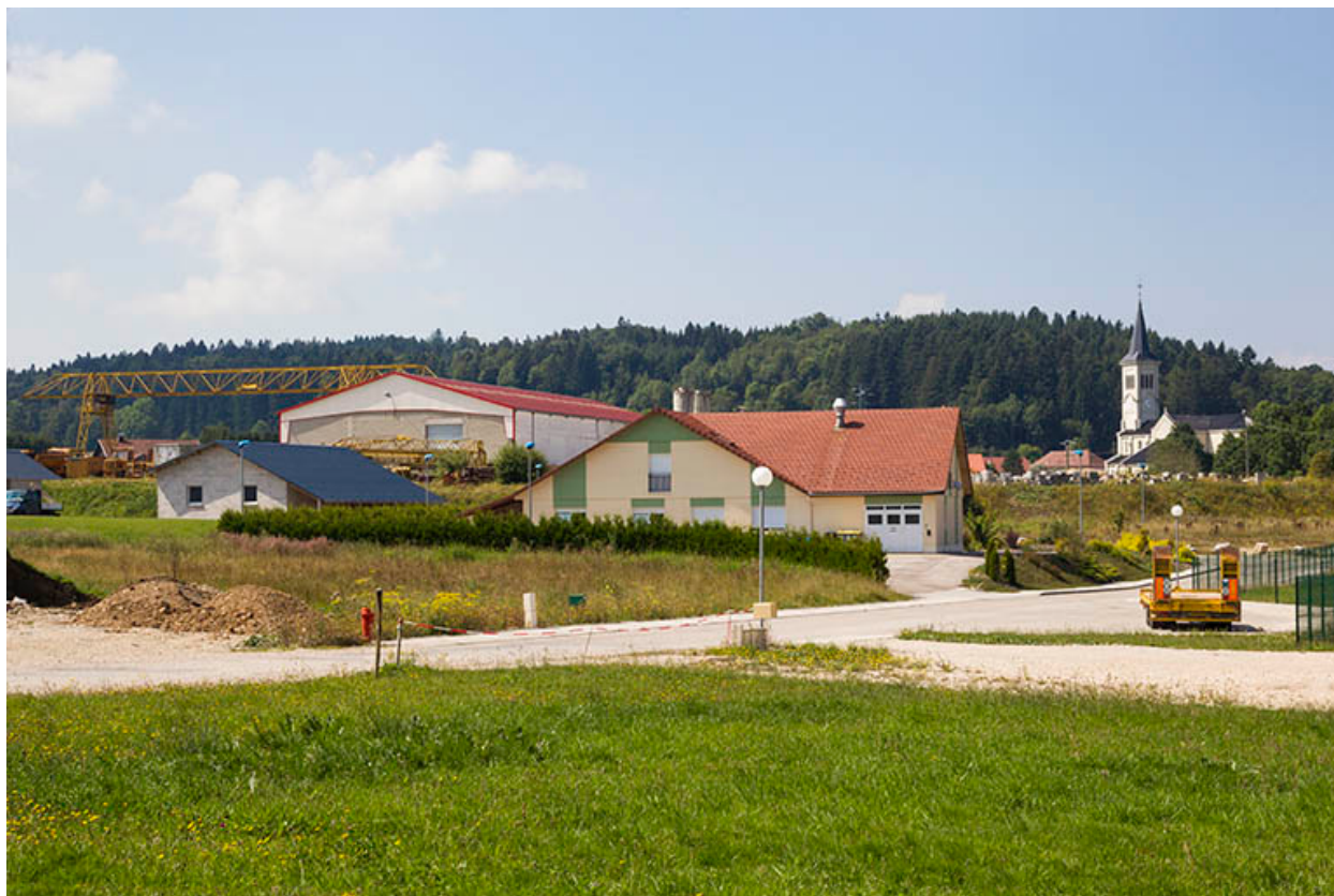
Vue d'ensemble, depuis l'est (façade postérieure).
